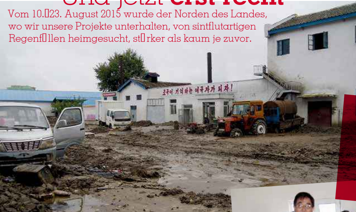
Durch die Fluten zerstört Bäckereien im Katastrophengebiet
